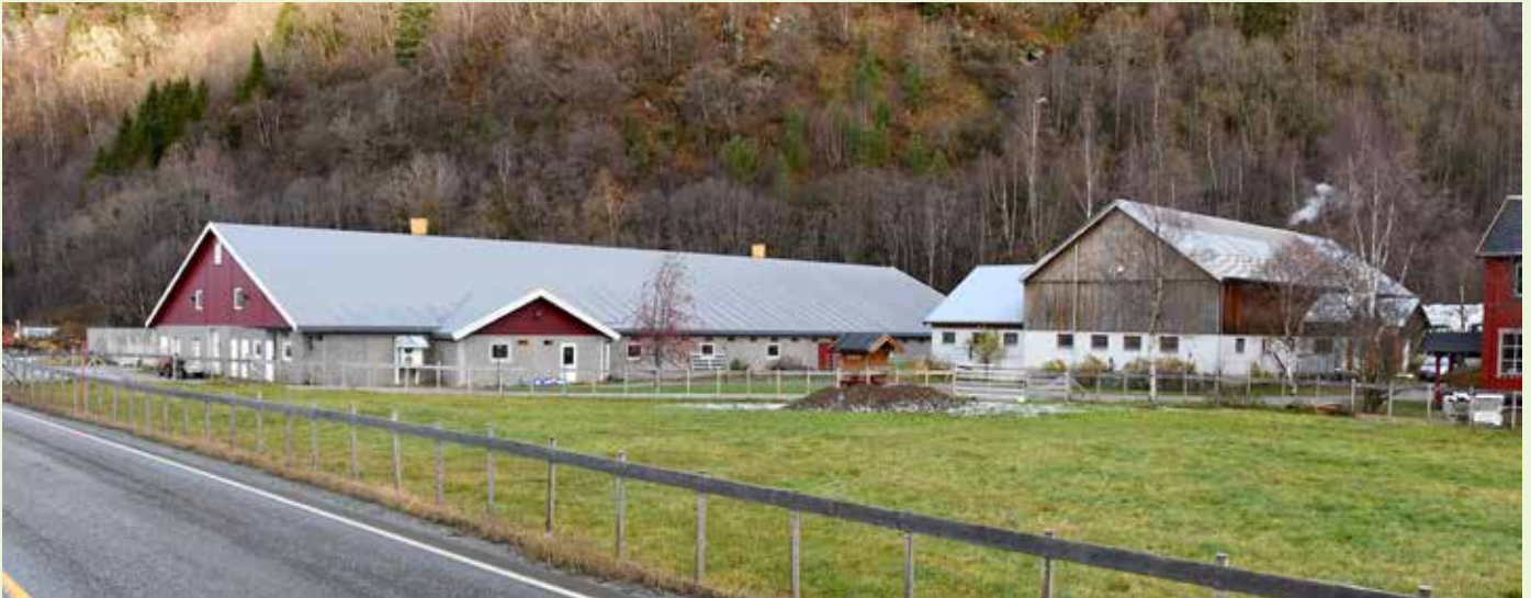
Samdriftsfjøset på Bergtun. Førsentralen er i enden på det gamle fjøset og fullfôrvogna går på skinner til nygjøset.
